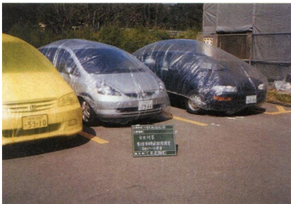
駐車カーシート養生
