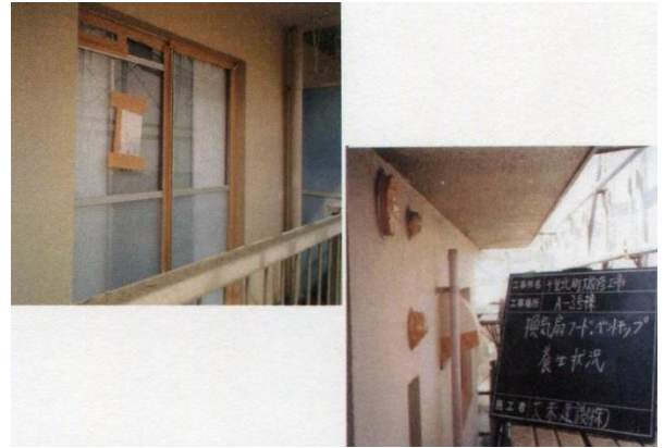
窓枠・換気扇・フード部テープ養生
