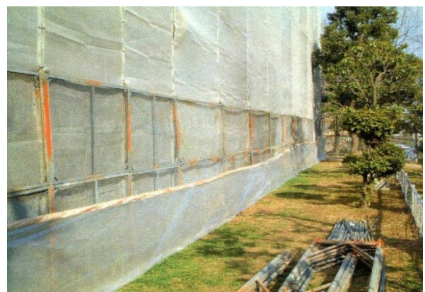
剥離水シート養生(外観)
