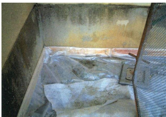
剥離水シート養生(コナ部)
